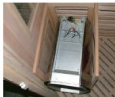
Brancher la ligne d'alimentation du poêle
